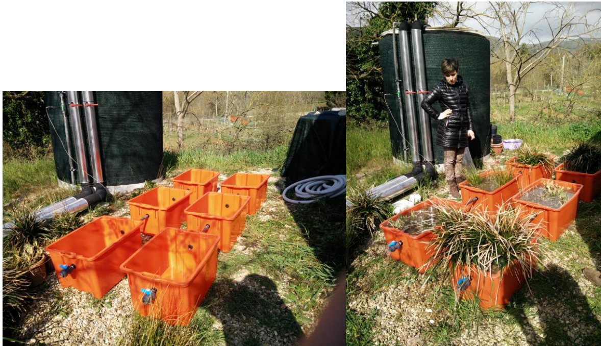
Figura 8. Predisposizione delle vasche e delle essenze per la fitodepurazione.
