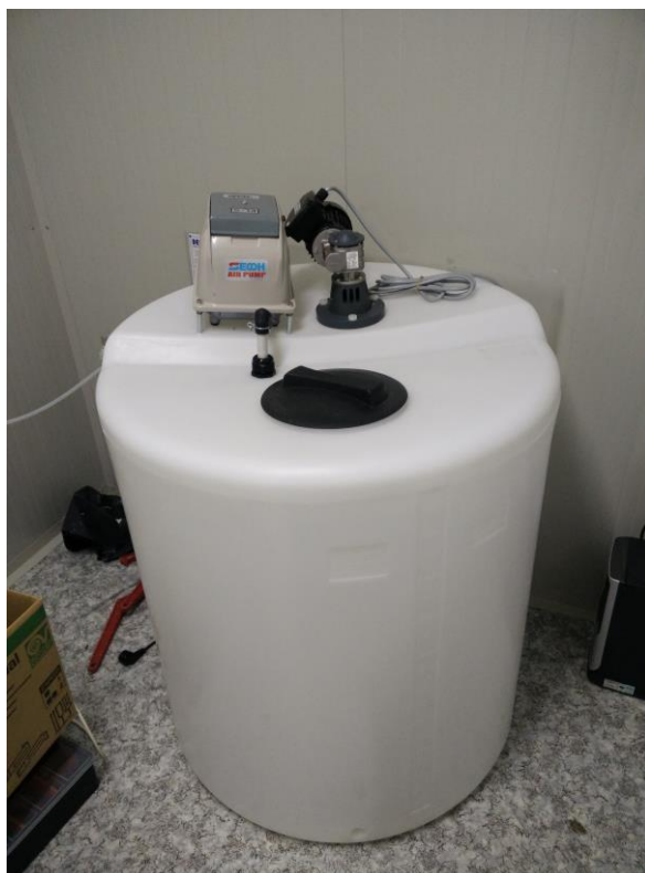
Figura 3. Serbatoio anossico/anaerobico.
